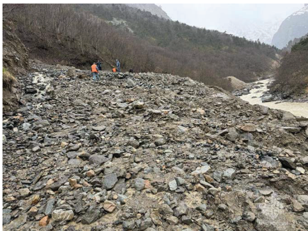
Рис. 1. Завал полотна автодороги Урвань-Уштулу селевыми выносами ручья Шуру-суу, 2 мая 2025 г.
