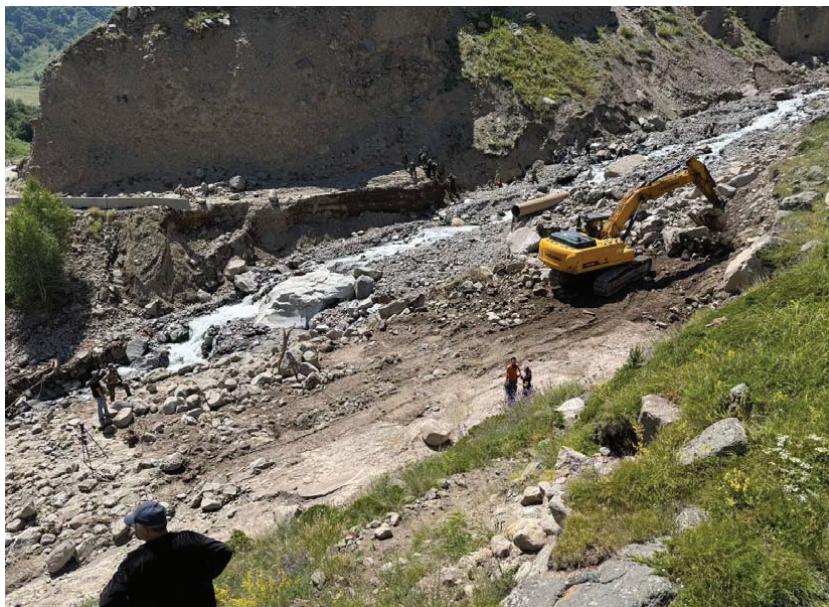
Рис. 6. Размыв автомобильной дороги Чегем – Булунгу селевым потоком 22 июля 2025 г.
