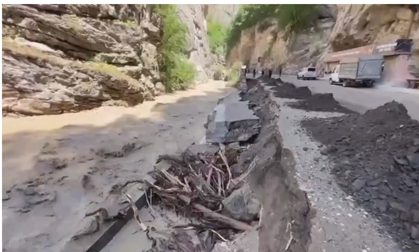
Рис. 7. Повреждение полотна автодороги наносоводным паводком по р. Чегем 22 июля 2025 г.
