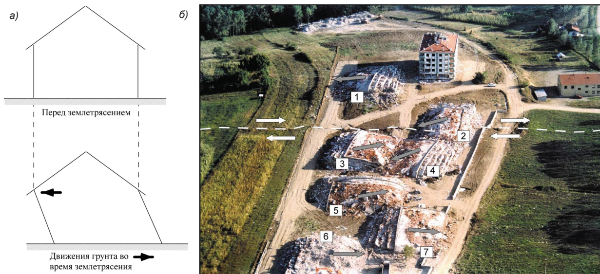
Рис. 6. Наклоны, обрушения и выдвигания верхних частей зданий во время сильных землетрясений:
