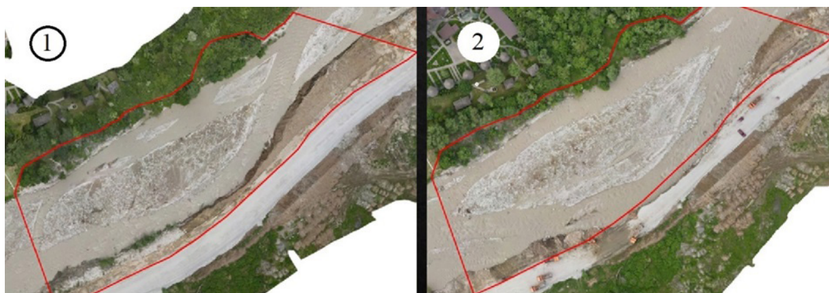
Рис. 2. Участок обрушения обьездной автодороги селевым потоком:
