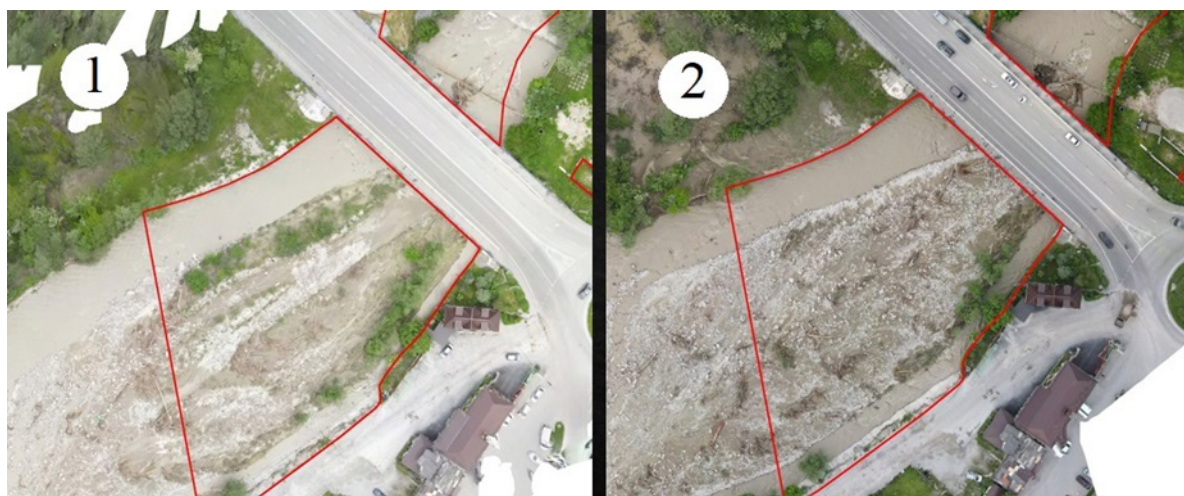
Рис. 3. Территория русла в зоне, прилегающей к автодорожному мосту:
