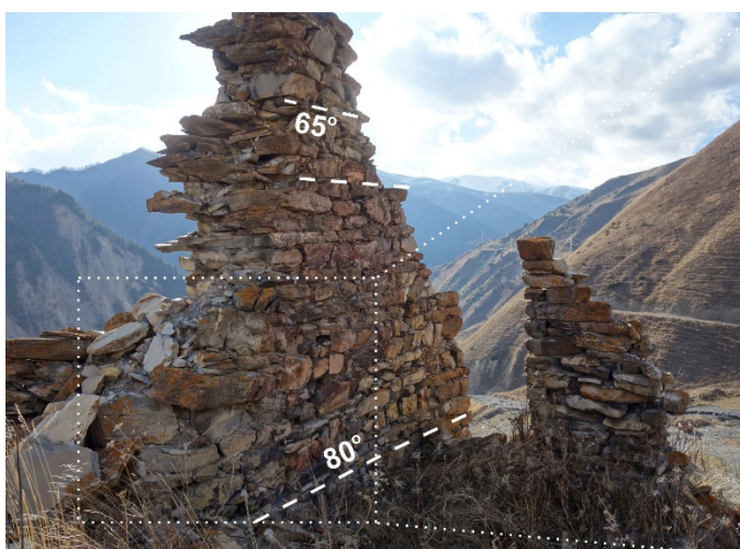
Рис. 16. Пропеллерный изгиб с разворотом против часовой стрелки и сквозные трещины во фрагменте южной стены постройки в юго-западной части верхнего квартала Тиба (3 на рис. 13); подписаны азимуты простираения фрагментов стены на разных гипсометрических уровнях
