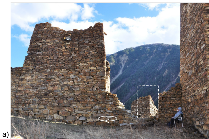
Рис. 6. Деформации Северной (4-й) башни и порталного простенка между ней и Высокой (5-й) башней:
