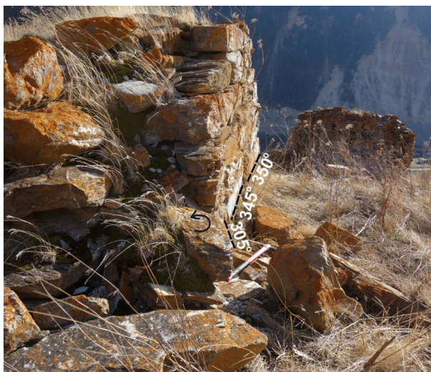
Рис. 15. Изгиб и надлом юго-восточной стены ганаха (жилища-башни) в южной части верхнего квартала Тиба (2 на рис. 13)
