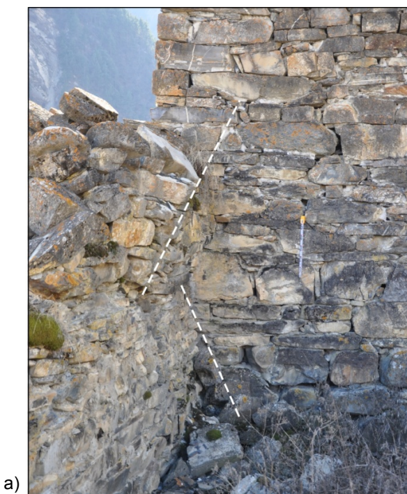
Рис. 7. Значительные изломы в восточной стене пристройки к Северной (4-й) башне поселения Тиб:
