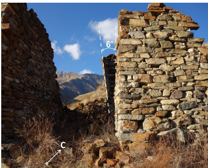
Рис. 18. Разрыв и наклон северной половины стены на юго-запад на северной окраине верхнего квартала Тиба (5 на рис. 13)
