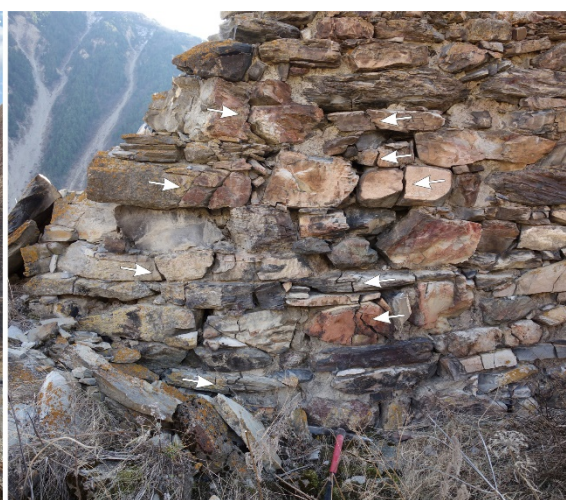
Рис. 16. Пропеллерный изгиб с разворотом против часовой стрелки и сквозные трещины во фрагменте южной стены постройки в юго-западной части верхнего квартала Тиба (3 на рис. 13); подписаны азимуты простираения фрагментов стены на разных гипсометрических уровнях
