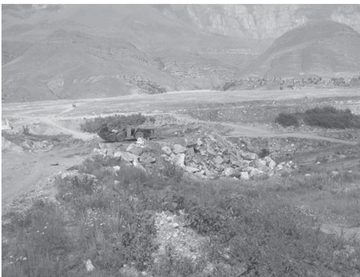
Рис. 1. Общий вид суперхранилища № 1. Проведение работ по поддержанию целостности дамбы после весеннего паводка 2005 года
