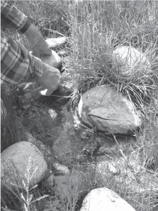
Рис. 2. Пробоотбор воды из ручейка, вытекающего из микронарушения в насыпной дамбе суперхранилища № 1
