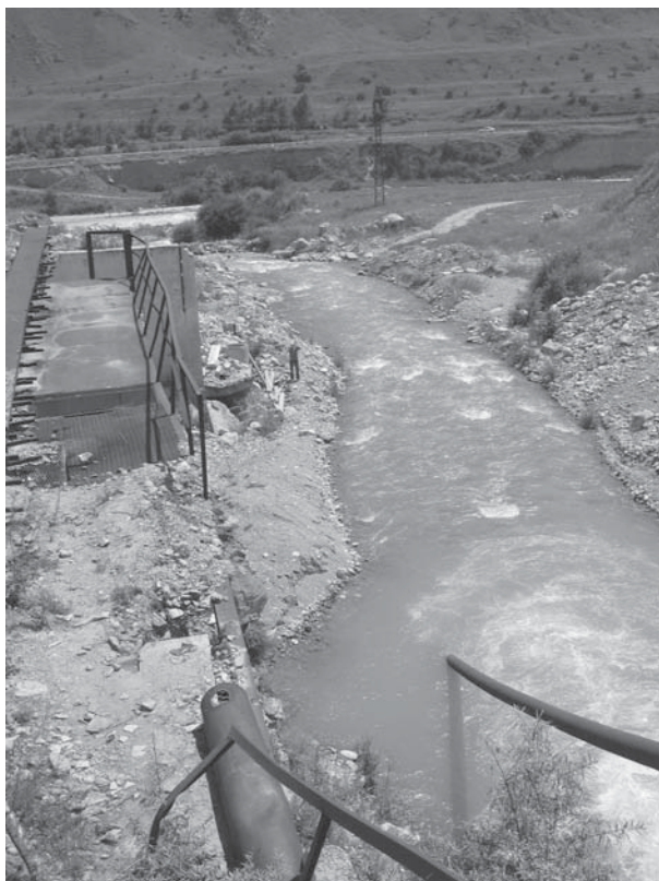
Рис. 3. Водоток из деривационного тоннеля в левом борту долины в районе суперхранилища № 1, впадающий в р. Баксан
