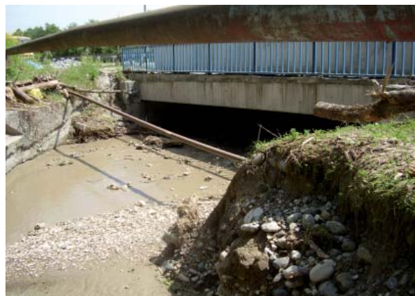
Рис. 5. 16 июня 2010 г. Мост на Транскаме с проходным сечением на расход водного потока р. Фашалгардон \leq 20 м 3 /с
