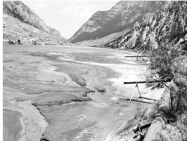
Рис. 1. Хвостохранилище Мизурской обогатительной фабрики. Вдали горизонтально виднеется водная часть (1), справа: сухая солевая часть (2), на переднем плане и далее справа: открытый сброс «хвостов» в чашу отстойника (3) Фото М.Э. Дзодзиковой, 2014 г.
