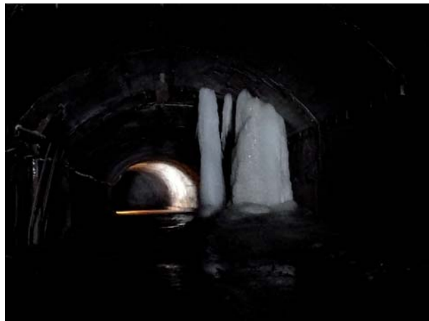
Фото 9. Наледи в автомобильном тоннеле около ЗарамагГЭС
