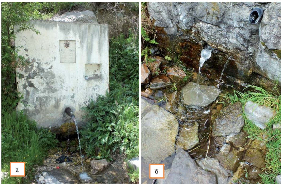
Фото 1. Прimitивно каптированные родники питьевой воды: а – на левом берегу р. Ардон, перед въездом в первый тоннель Транскама (р-н местечка Чырамад); б – на левом берегу р. Фиэгдон, чуть выше ее левого притока р. Цажилдон (фото Дзодзиковой М.Э.)
