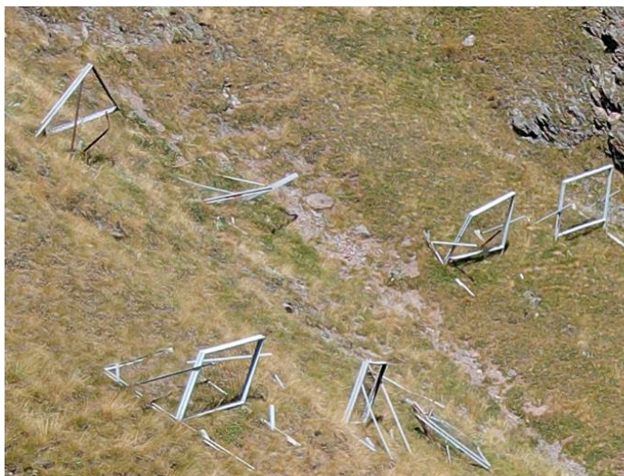
Рис. 5. Снегоудерживающие сооружения, пришедшие в негодность (фото с квадрокоптера 30.08.2022 г.)
