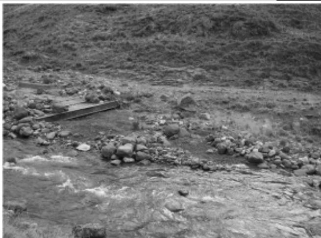
**Рис. 6. 10 октября 2006 г. Разрушенный и занесенный селевым потоком 1997 года мост через Кара-Кая-Су. Снимок Э. Запорожченко**
